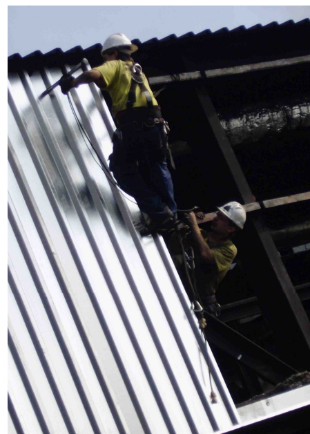
Plech je nutno z vnitřní strany přitáhnout přísavkami ke konstrukci.
