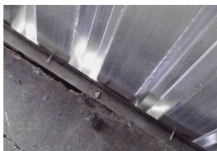
Spojení pláště a parapetu šrouby TEX.
