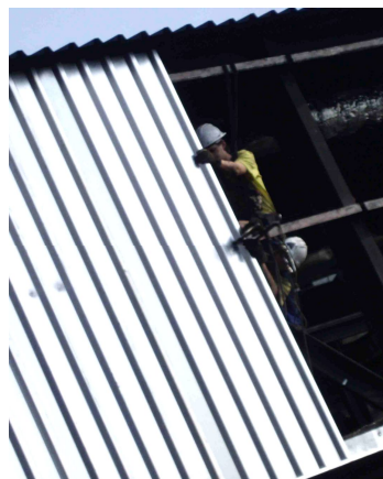
První uchycení plechu na střední úhelník svěrkou.
