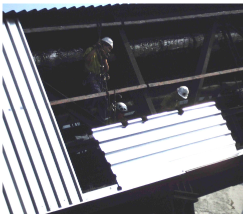
Vkládání plechu na konstrukci a parapet.
